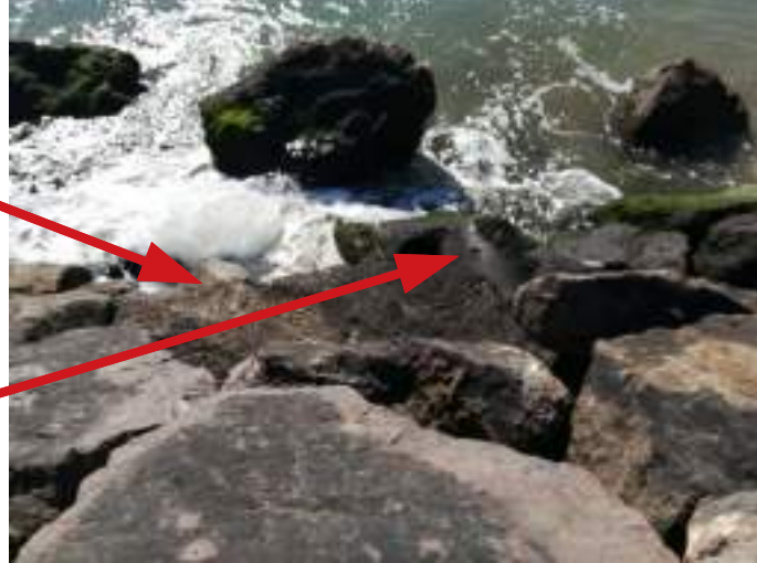
FOTO 1. PERSPECTIVA 1 DE LA POSICIÓN DE LOS COLECTORES DE LA EDAR DE BURRIANA. COLECTOR DE VERTIDO DE AGUAS DEPURADAS Y DE DRENAJE DE AGUAS PLUVIALES.
