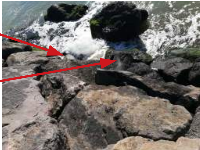
FOTO 2. PERSPECTIVA 2 DE LA POSICIÓN DE LOS COLECTORES DE LA EDAR DE BURRIANA. COLECTOR DE VERTIDO DE AGUAS DEPURADAS Y DE DRENAJE DE AGUAS PLUVIALES.
