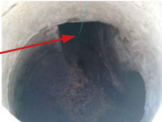
FOTO 4. ARQUETA DE SALIDA DEL COLECTOR DE AGUAS PLUVIALES RECOGIDAS EN LA EDAR. DIÁMETRO DEL COLECTOR DN = 630 MM
