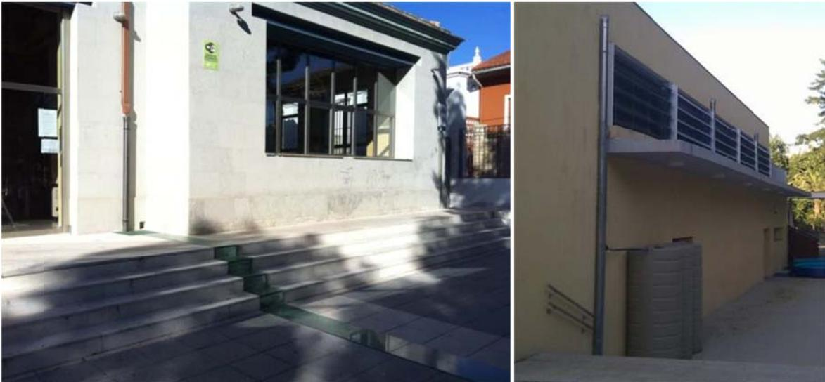
**Figura 1.** Sistemas de reaprovechamiento de aguas captadas en cubiertas de edificios públicos en Benaguasil (izquierda) y Xàtiva (derecha).
