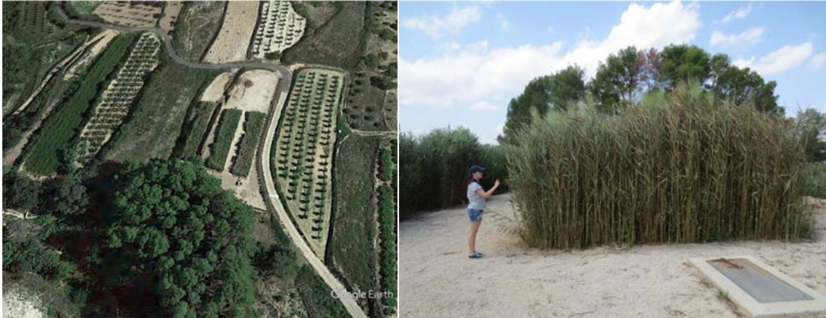
**Figura 1.** Izquierda: vista general de las tres celdas de HA subsuperficial de Carrícola (Valencia); Derecha: detalle de una de las celdas en septiembre de 2016.
