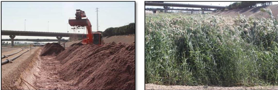
**Figura 4.** Izquierda. HA de la V30-Pinedo durante la fase de construcción. Detalle de la celda con óxidos de hierro como material adsorbente y arena como sustrato principal. Derecha. Desarrollo del carrizo en esa misma celda tras un año de operación
