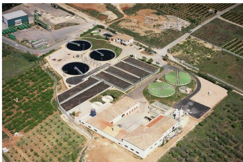
Figura 11. Imagen aérea de la EDAR de Denia-Ondara-Pedreguer Fuente: EPSAR. http://www.epsar.gva.es/instalaciones/Fotos/102.jpg
