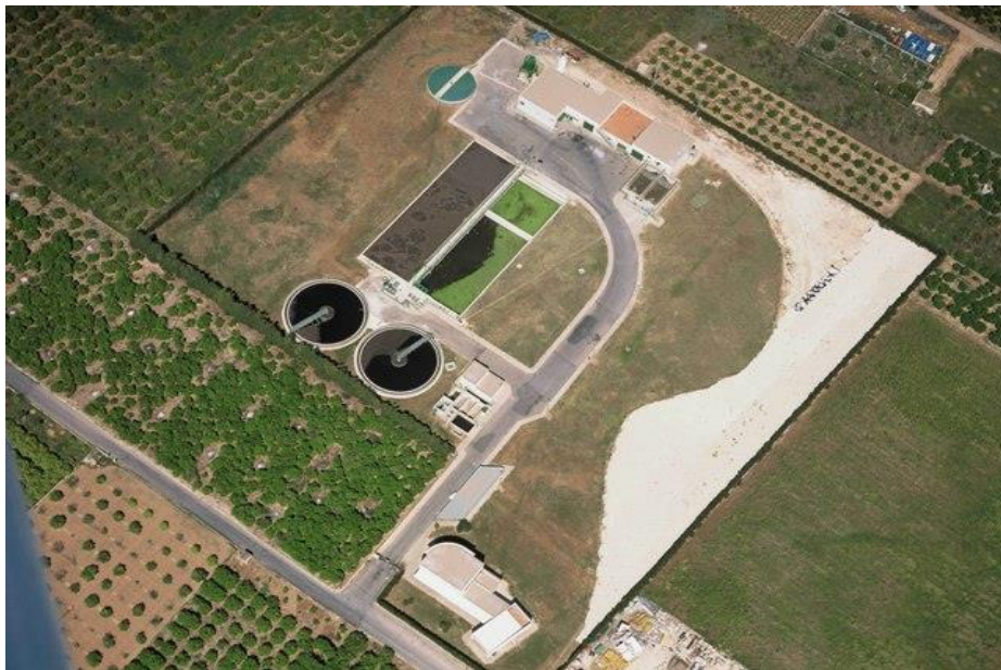
Figura 12. Imagen aérea de la EDAR de Xàbia. Fuente: EPSAR http://www.epsar.gva.es/sanejament/instalaciones/Fotos/443.jpg
