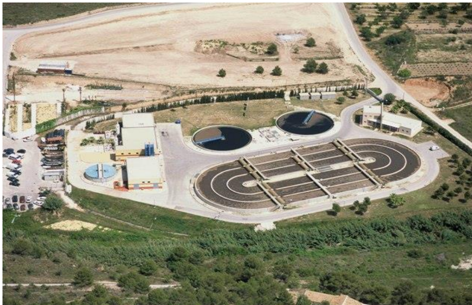
Figura 13. Imagen aérea de la EDAR de Calp. Fuente: EPSAR . http://www.epsar.gva.es/instalaciones/Fotos/323.jpg
