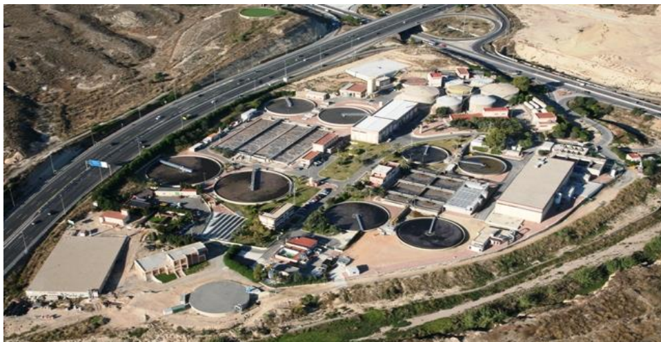
Figura 17. Imagen aérea de la EDAR de Rincón de León. Fuente: EPSAR. http://www.epsar.gva.es/sanejament/instalaciones/Fotos/5.jpg
