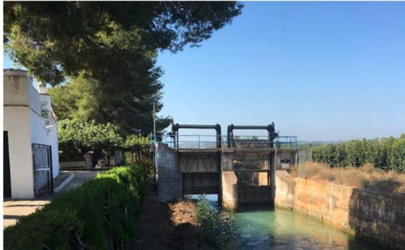
Ilustración 7: Compuertas instaladas junto al centro de operación de la ARJ.
