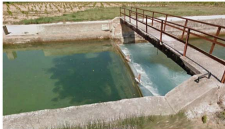
Ilustración 4: Parada de elevación de niveles en "puente Gabarda".
