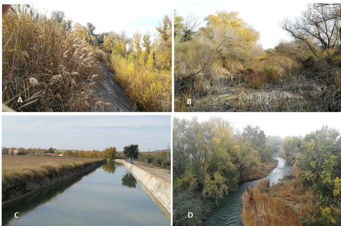
Figura 4.- Imágenes del río Tajo en los alrededores del azud de Valdajos. (A): Vista parcial del azud de Valdajos, recubierto en gran parte por la vegetación, indicando la falta de caudal circulante aguas abajo. (B): Tramo seco del río Tajo que abarca desde el azud de Valdajos hasta la central del mismo nombre. (C) Agua del Tajo circulando por el Caz de Valdajos. (D) Cauce del río Tajo aguas abajo de la central de Valdajos, a partir de la cual el río recupera su caudal.
