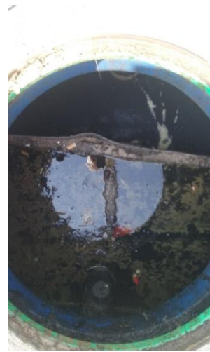
Figura 8. Interior separador de hidrocarburos
