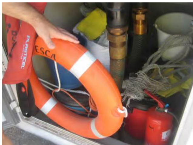
Figura 6. Cuarto de bombas
