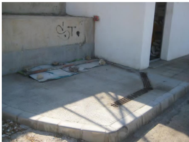
Figura 5. Zona de descarga
