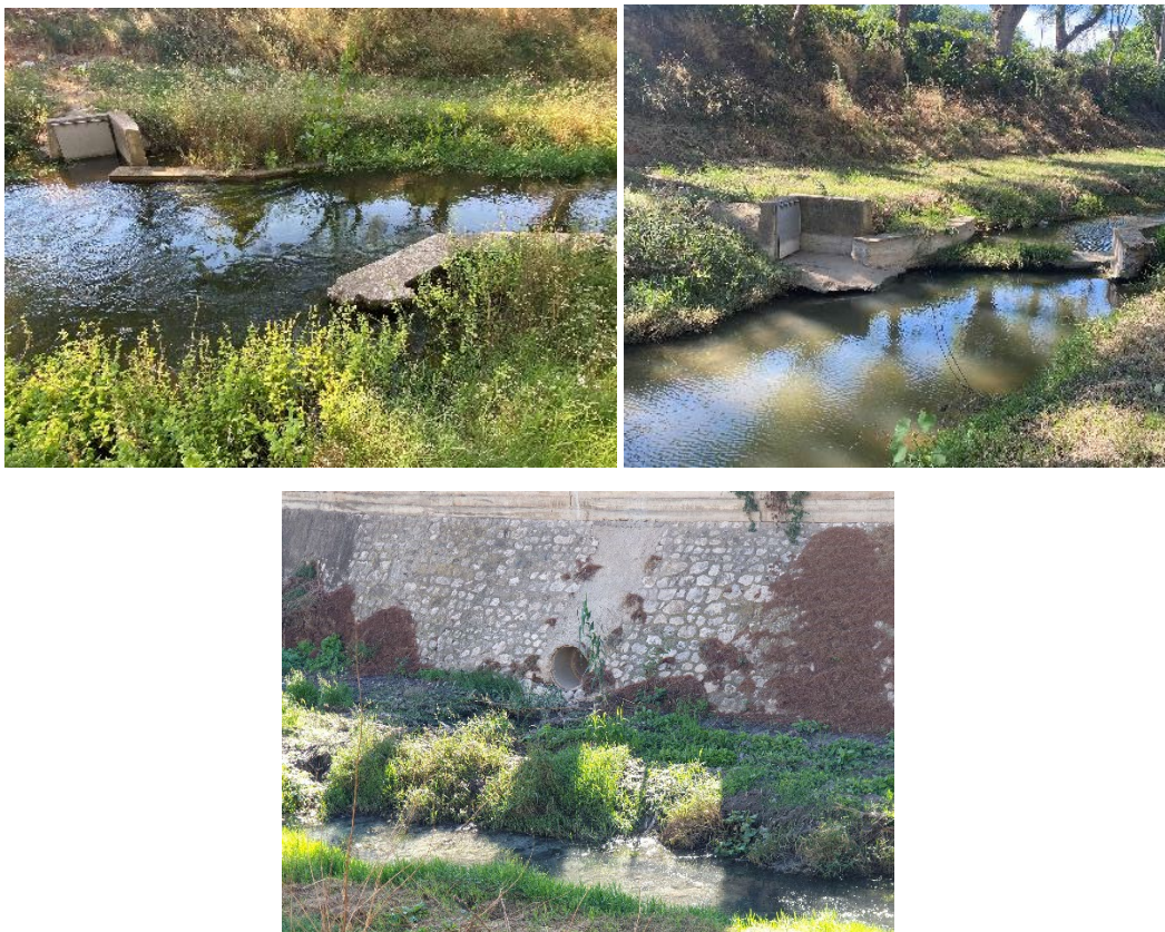
Figura 9. Sobreixidors en el Bnc. de Picassent a l'altura de Beniparrell.
