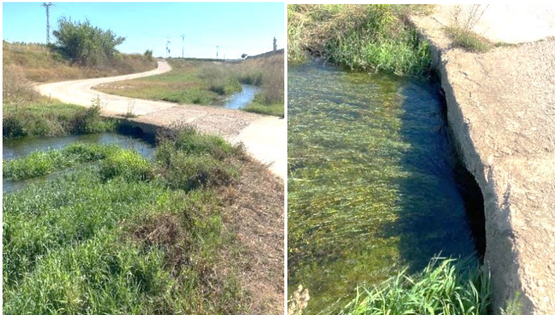
Figura 12. Obra de drenatge transversal en punt 1 (vista des d'aigües amunt) durant els mesuraments (28-jun)
