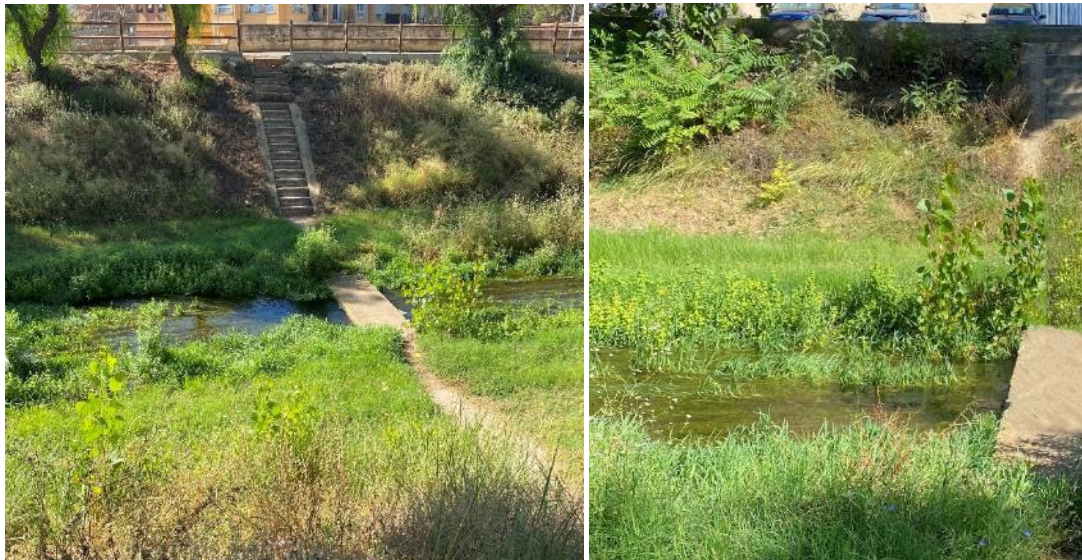
Figura 14. Passarel·la i secció transversal en punt 2 durant els mesuraments (28-jun)
