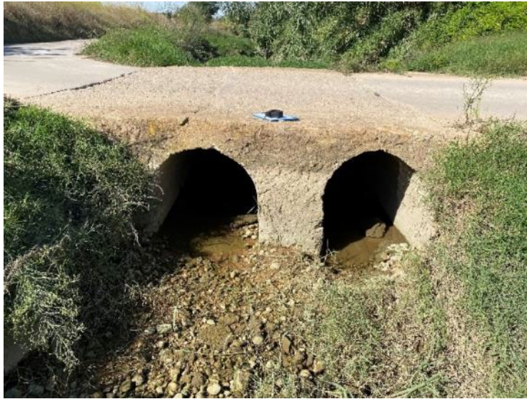
Figura 11. Obra de drenaje transversal en punto 1 (vista desde aguas abajo) (29-sept)
