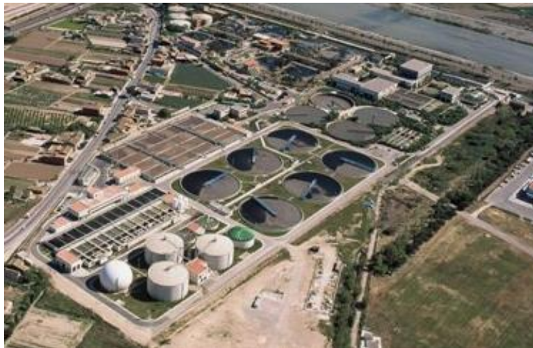
Figura 13. Fotografia aèria EDAR Pinedo 2 (font EPSAR)
