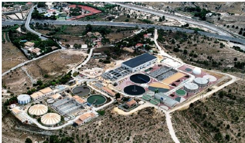
Figura 21. Fotografia aèria EDAR Mont Orgègia (font EPSAR)
