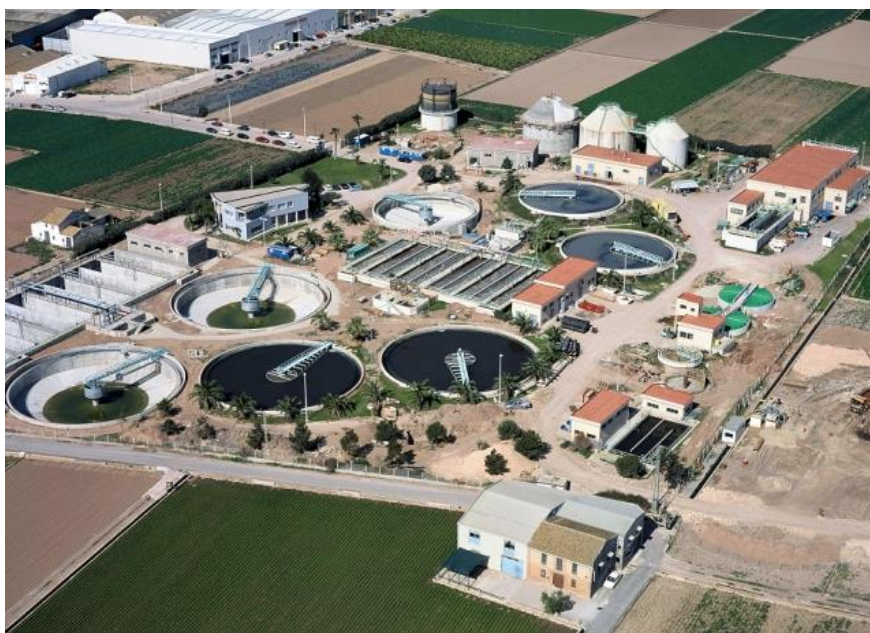
Figura 5. Fotografia aèria EDAR Conca del Carraixet (font EPSAR)
