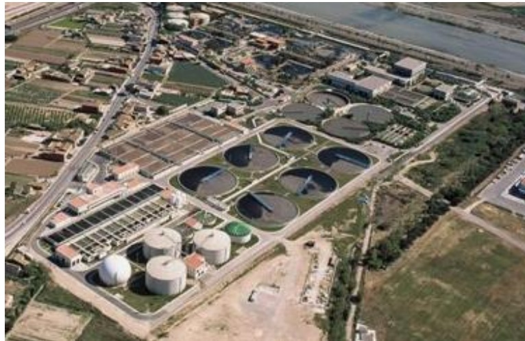
Figura 11. Fotografia aèria EDAR Pinedo 1 (font EPSAR)
