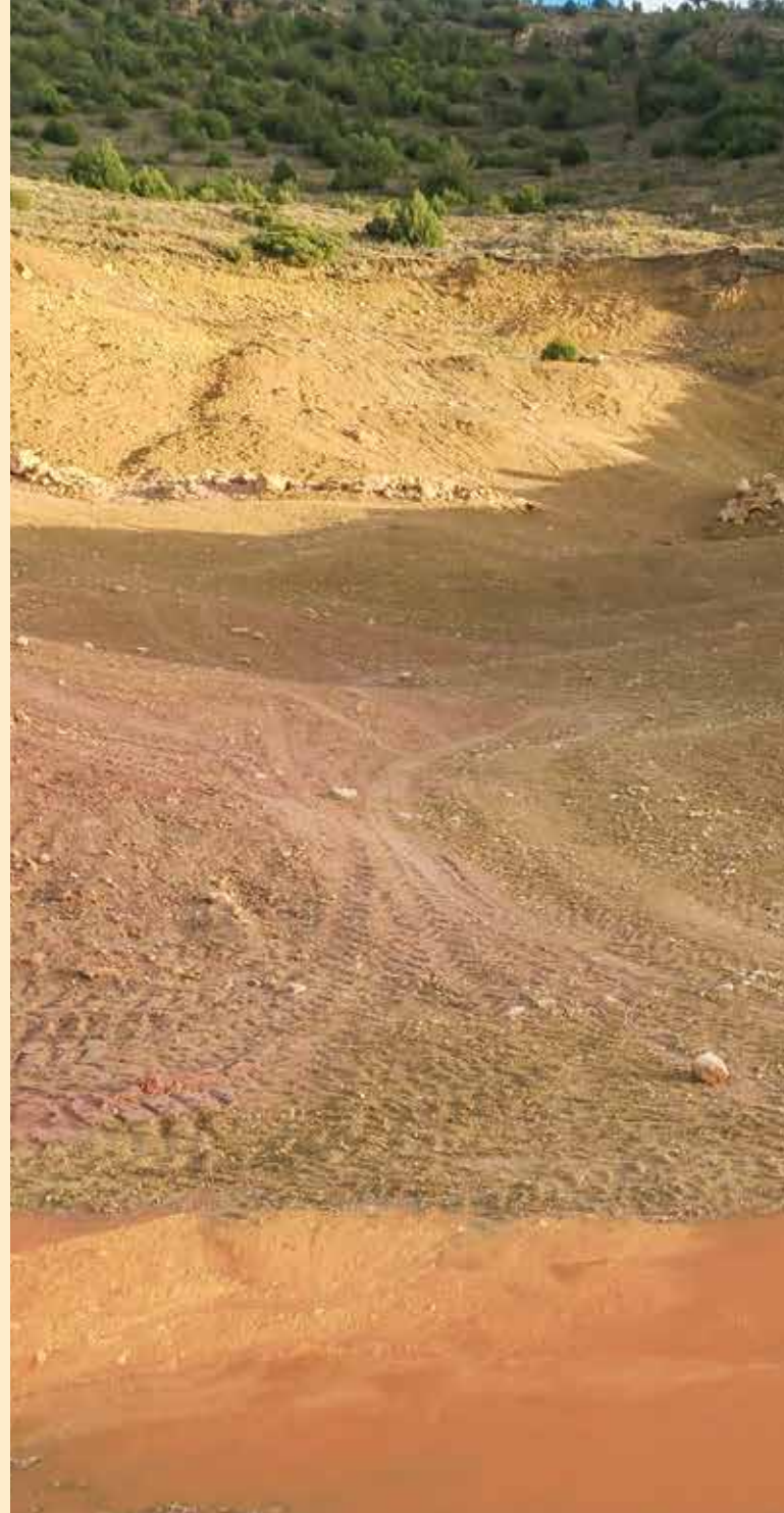
Vista de una de las laderas tras los trabajos de remodelado del terreno. View of one of the slopes after terrain regrading works.
