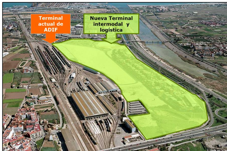
Figura 3. Nueva Terminal Intermodal y Logística. Fuente: Adif
