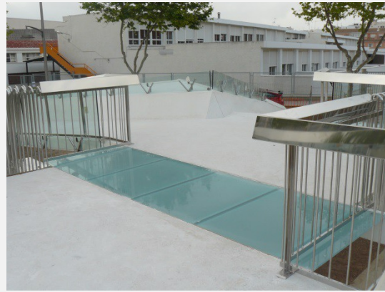
Unión y materiales definidos en obra
