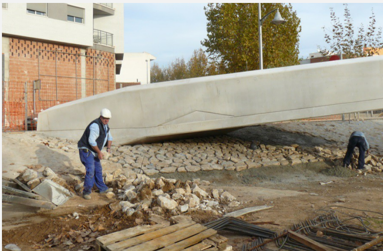
Encachado añadido en obra
