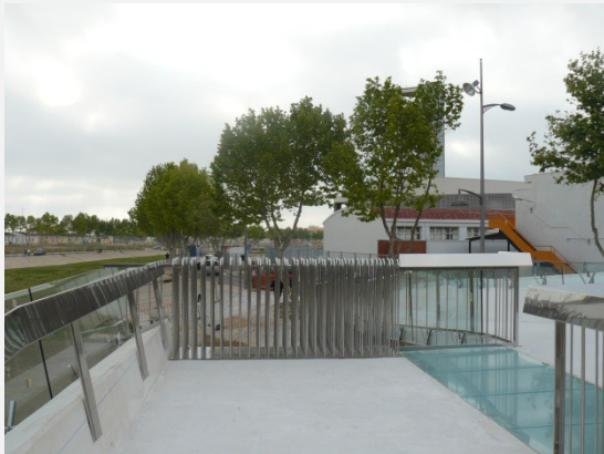
Barrera de cierre definida en obra
