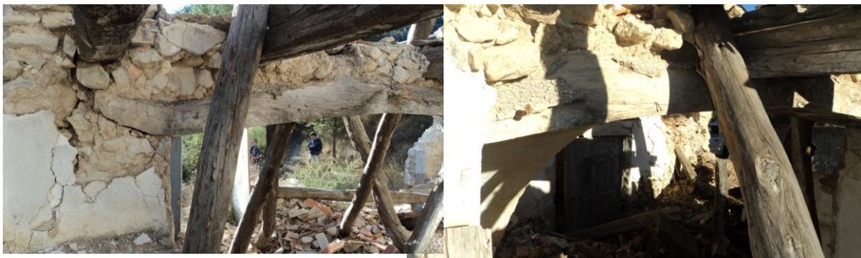
Fig. 8. Utilización de la madera del quejigo como viga en el Mas del Retir.
