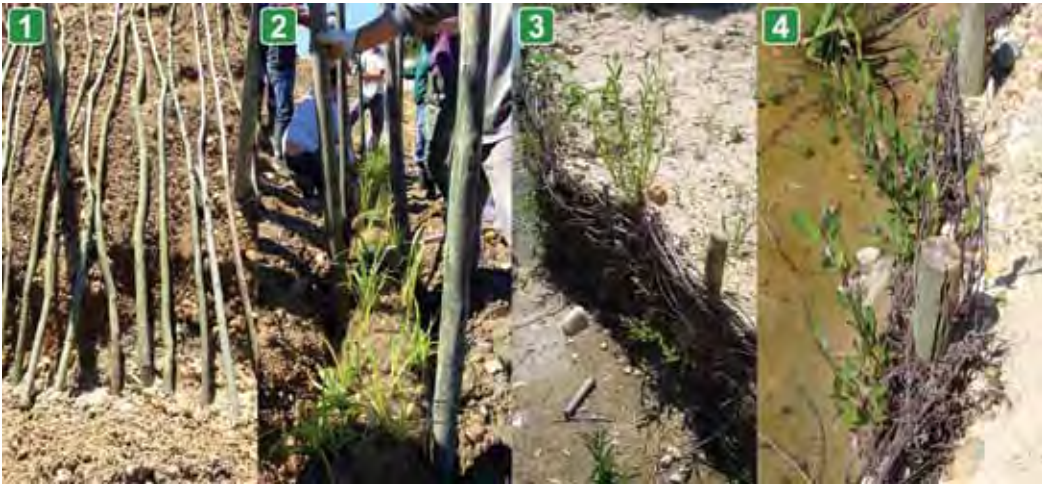
Figura 5.1.25 Aspecto del trenzado vivo (1), las fajas (2), la estera de ramaje (3) y el biorollo (4) (fotos: Regina Carriço, 1 y 2, y André Fabião, 2 y 3).
