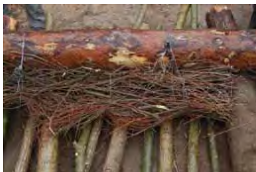
Figura 4.5.1.4 Una fajina como estructura de retención de material fino en un entramado de madera (foto: Joaquim Bosch)
