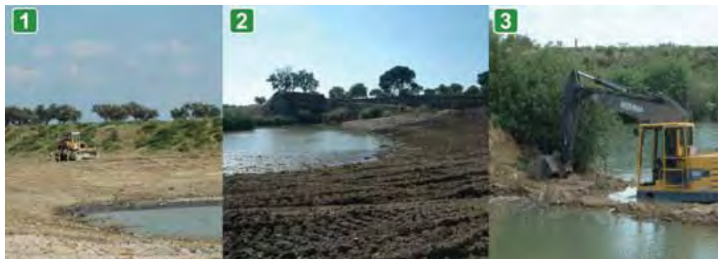
Figura 5.1.20 Aspecto final del desarrollo de los trabajos (1 y 2) y problemas de hundimiento de la maquinaria, debido a la alta pendiente del talud inmerso bajo el agua (3) (fotos: Ana Mendes).
