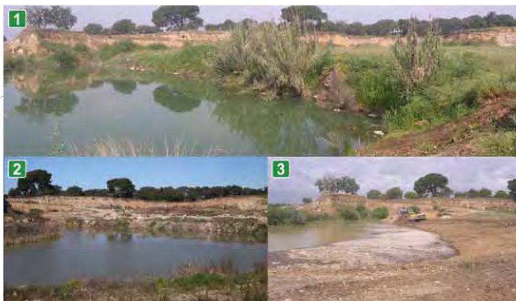
Figura 5.1.7 Aspecto general previo a los movimientos de tierras (1 y 2) y durante la fase final de los trabajos de modelación del terreno (3). (foto: Ana Mendes).
