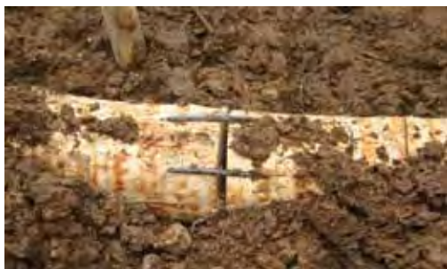
Figura 4.5.5.2 Unión de dos troncos con grapas de hierro corrugado (foto: Antoni Bonafont).
