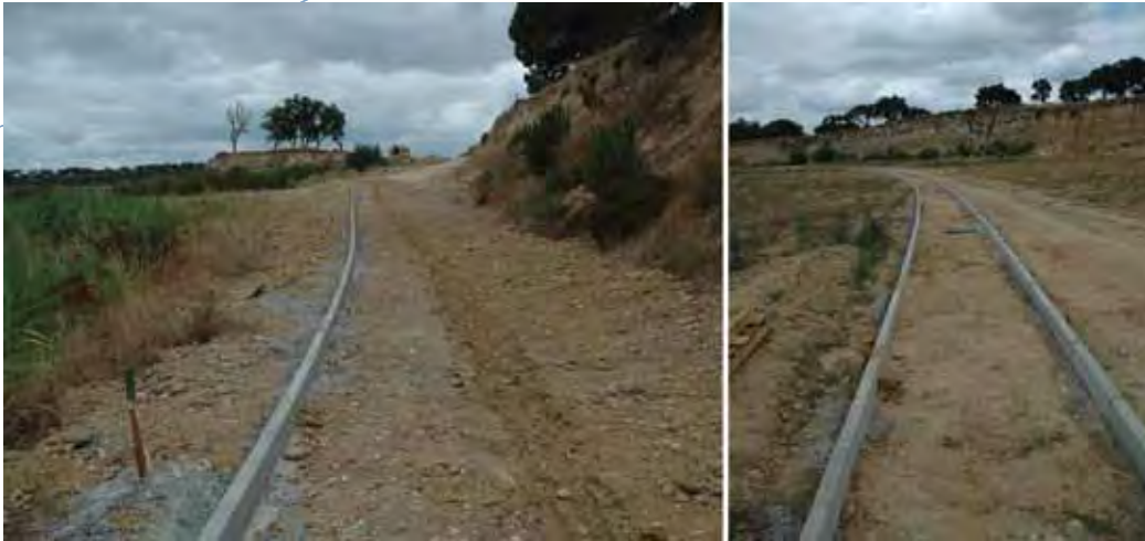
Figura 5.1.8 Vista general de la instalación en el terreno de las cunetas de las sendas de interpretación (fotos: Ana Mendes).
