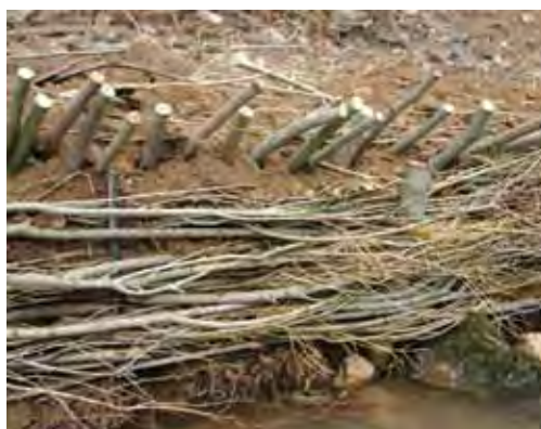
Figura 4.5.3.4 Vista frontal de un trenzado reforzado con estacas vivas. Río Tuéjar (Valencia, España) (foto: Antoni Bonafont).
