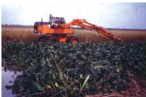
Figura 4.6.1 Retroexcavadora hidráulica operando una cuba de limpieza desde el margen de un canal (foto: Ilídio Moreira).
