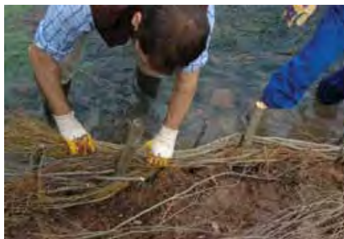
Figura 4.5.3.3 Trenzado de ramas de sauce alrededor de estacas vivas. Río Tuéjar (Valencia, España) (foto: Ana Mendes).
