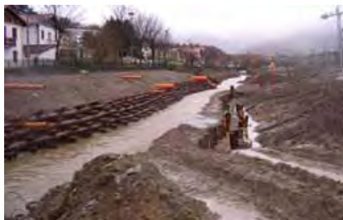
Figura 4.5.5.4 Construcción de un entramado de madera en tramo urbano. Río Artia (Guipúzcoa) (foto: Paola Sangalli).
