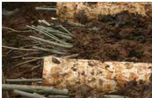
Figura 4.5.5.3 Colocación de estacas de sauce en las celdas del entramado de madera y cubiertas con tierra vegetal (foto: Antoni Bonafont).
