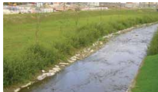
Figura 4.5.4.5 Estera de ramaje en un tramo urbano. Río Artía en Irún, Guipúzcoa) (foto: Paola Sangalli).
