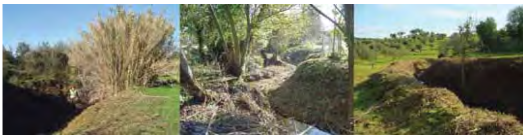
Figura 5.2.3 Ejemplos del trabajo de restauración contratado realizado a lo largo de los dos tramos (el afluente Gandum y el río Almansor) (foto: Filipa Pais).
