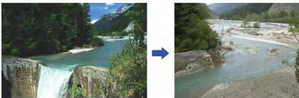
Figura 5.5.7 Eliminación de los diques de retención de sedimentos, ejemplo Hornbach.
