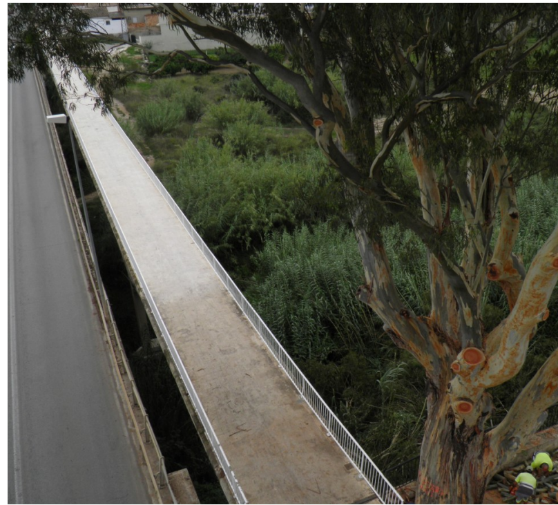
Despeje de ramas sobre la pasarela y la carretera CV-50 para reducir el riesgo de accidente.
