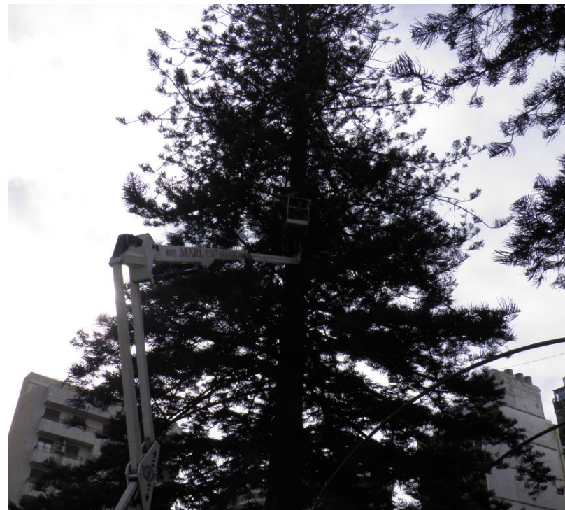
Actuación con máquina elevadora.
