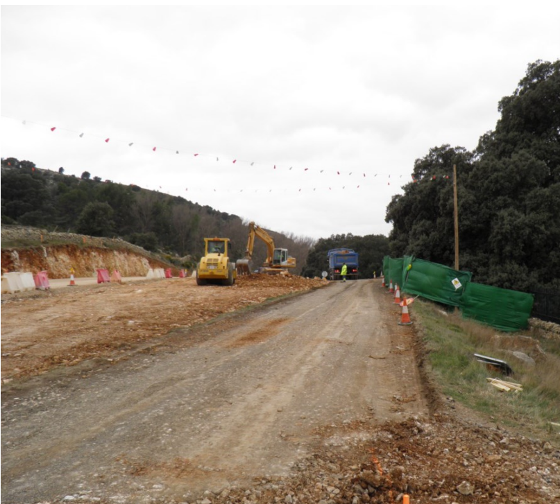
Ejecución de los trabajos.
