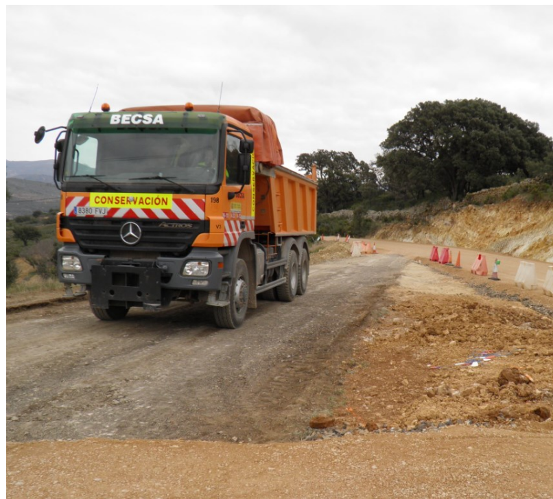
Ejecución de los trabajos.
