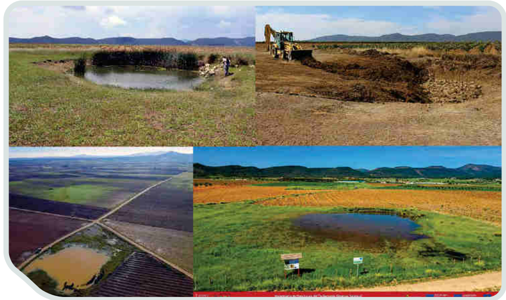
Figura 4. Las Microrreservas de Flora facilitan la ejecución de grandes proyectos de restauración. En la MRF Lavajo del Tío Bernardo (Sinarcas, Valencia) se restauró el perfil de una laguna temporal que había sido excavada en los años 70. Las imágenes muestran el estado inicial, el desarrollo de los trabajos y el estado final de la laguna pocos meses después de finalizada la obra. En la parte inferior derecha, póster de la serie "Hábitats Protegidos de las Comunidad Valenciana" que atiende los objetivos de formación y divulgación que también promueve el proyecto de las Microrreservas.
