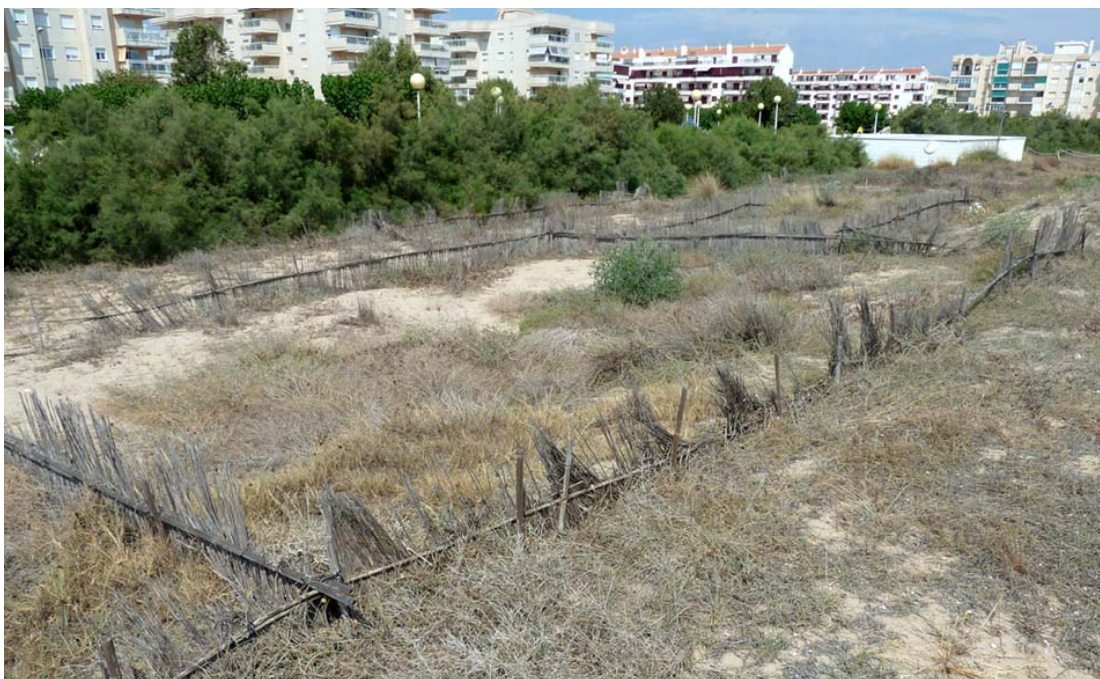
Imagen 2. Restos de los recintos instalados en la playa de Daimús (Valencia) en el marco de las actuaciones realizadas por la Demarcación de Costas de Valencia para la fijación de las dunas y la restauración de la cubierta vegetal tras la eliminación de Carpobrotus . Imagen tomada en junio de 2014.
