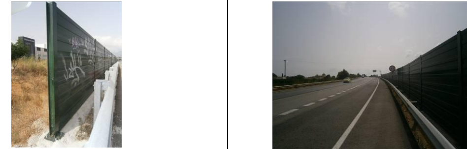
Figura 2. Pantallas acústicas margen derecho CV-725 PK 3+600 al PK 3+830
