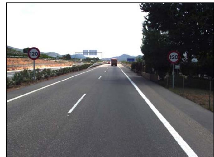
- V límite carretera. Tramo 010-080 - Entre P.K.28+300 y P.K.33+300
