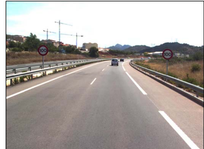
- V límite carretera. Tramo 010-080 - Entre P.K.25+770 y P.K.28+300
