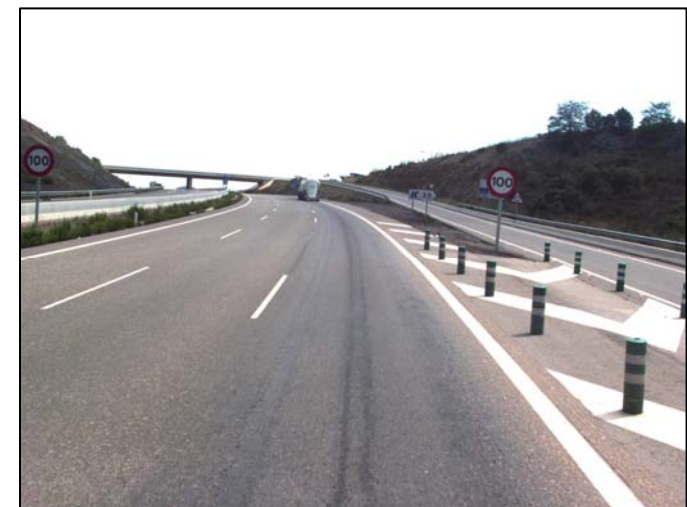
- V límite carretera. Tramo 010-090 - Entre P.K.34+700 y P.K.36+700
