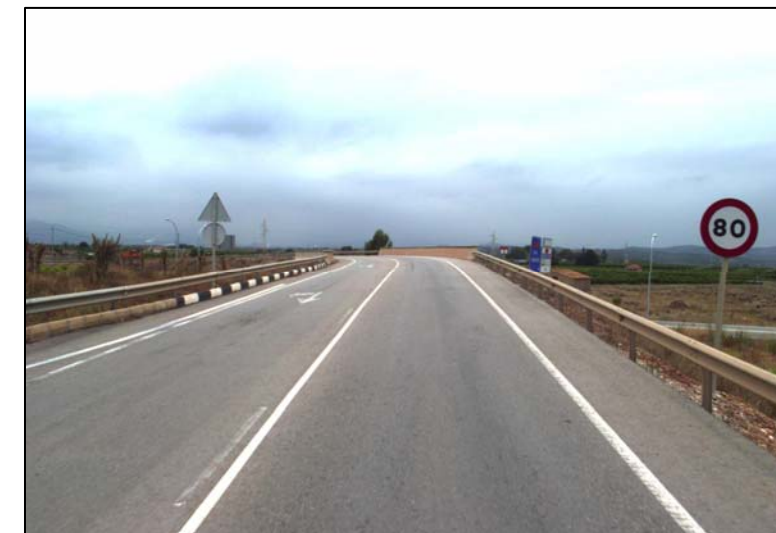
- V límite carretera. Tramo 017-010 - Entre P.K.2+970 y P.K.3+040
