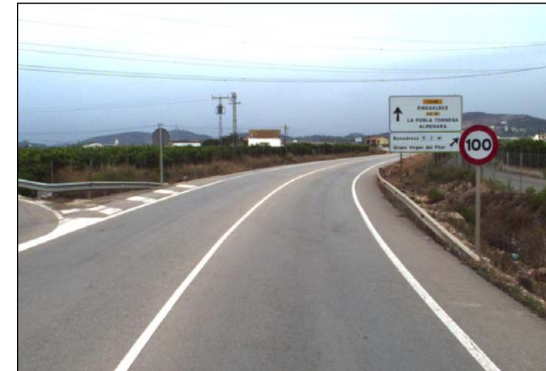
- V límite carretera. Tramo 017-010 - Entre P.K.0+000 y P.K.2+970
