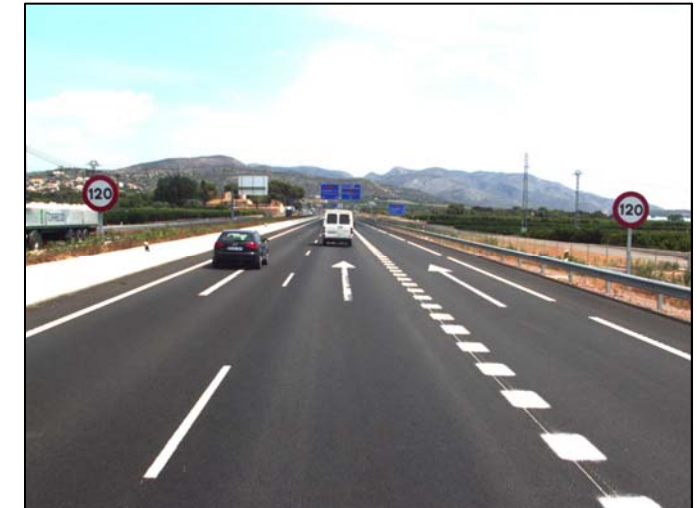
- V límite carretera. Tramo 010-070 - Entre P.K.23+000 y P.K.25+050
