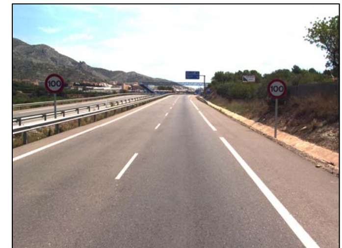
- V límite carretera. Tramo 010-070 - Entre P.K.25+050 y P.K.25+770
