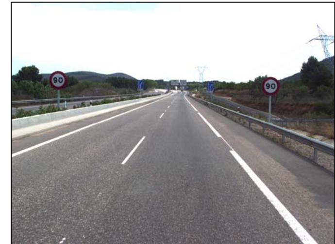
- V límite carretera. Tramo 010-090 - Entre P.K.36+700 y P.K.37+500
