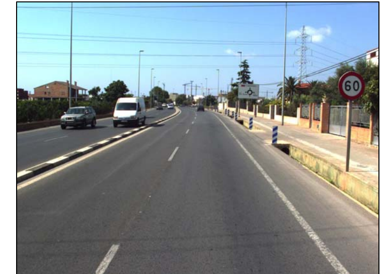
- V límite carretera. Tramo 018-010 - Entre P.K.0+000 y P.K.1+200
