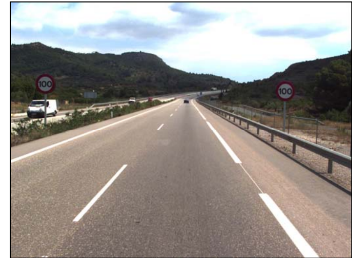
- V límite carretera. Tramo 010-080 - Entre P.K.33+300 y P.K.34+700
