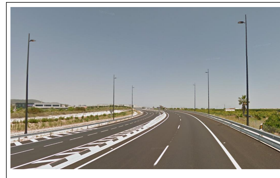
Ilustración 1: Alumbrado existente en N-332
