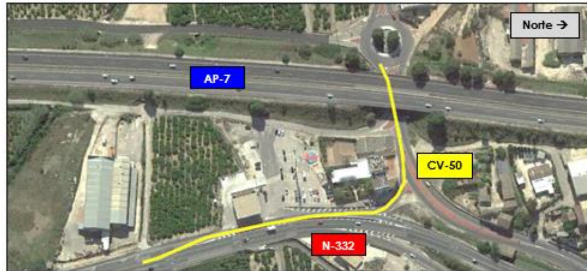
Imagen 9. Conexión actual de la CV-50 con la N-332 hacia el sur.
