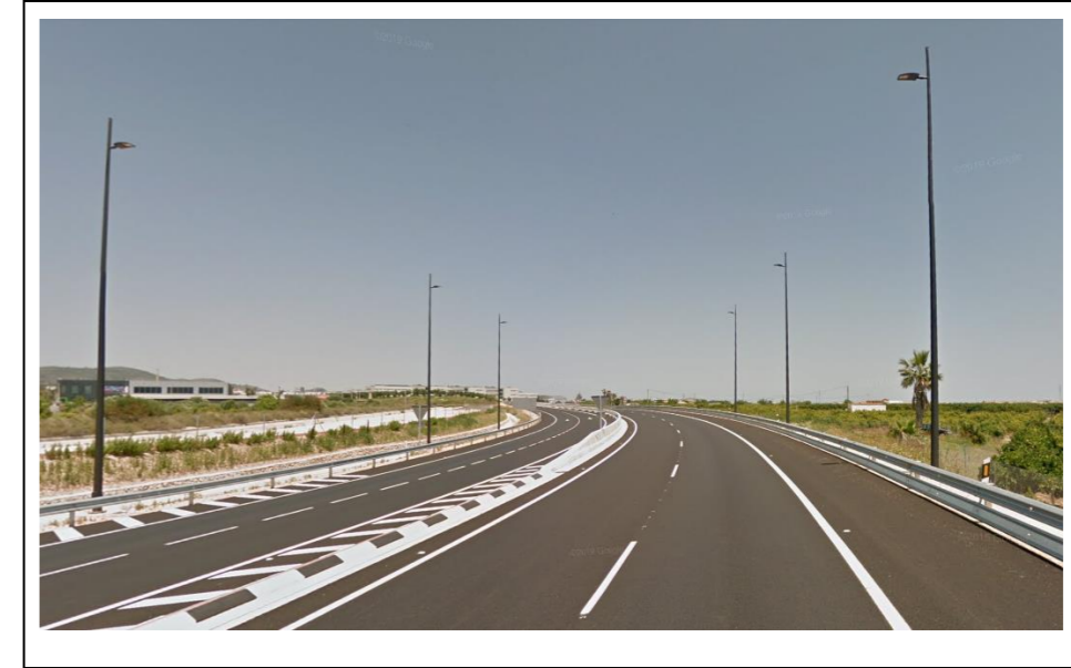
Ilustración 1: Alumbrado existente en N-332
