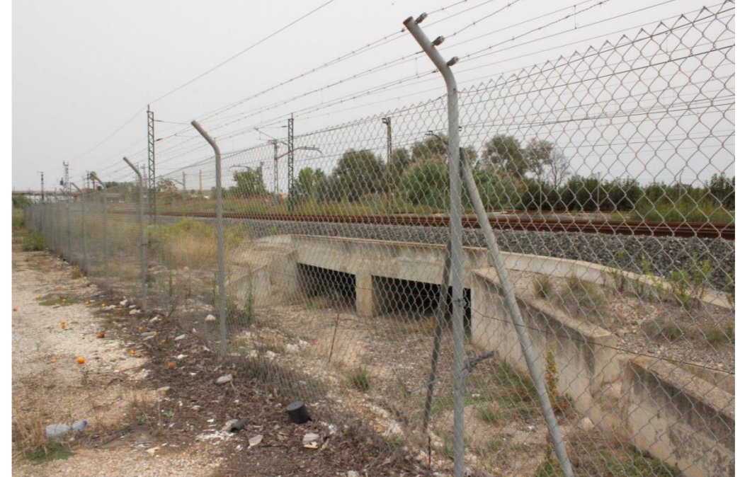
Foto 23.- Detalle obra de fábrica bajo el ffcc.
