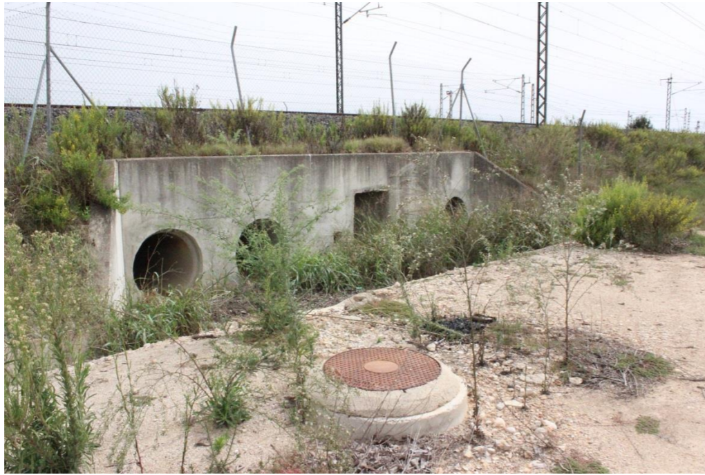
Foto 28.- Detalle Obras de drenaje bajo el fcc pasada la subestación.
