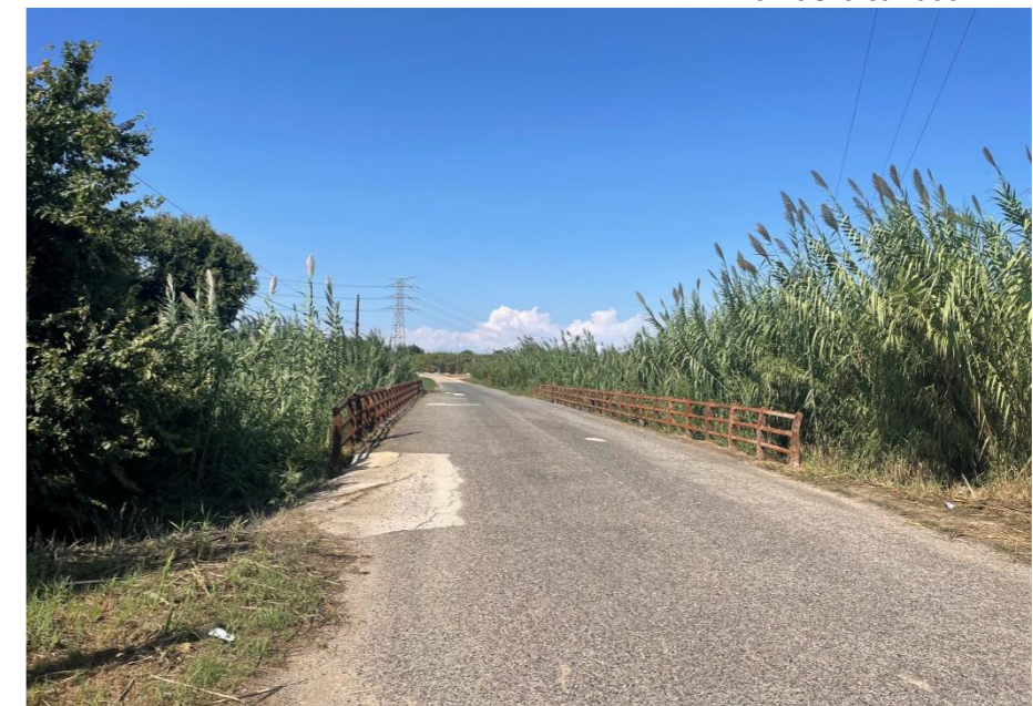
Foto 5.- Calzada de Acceso al Polígono Industrial por Carrer Democracia en sentido norte.
