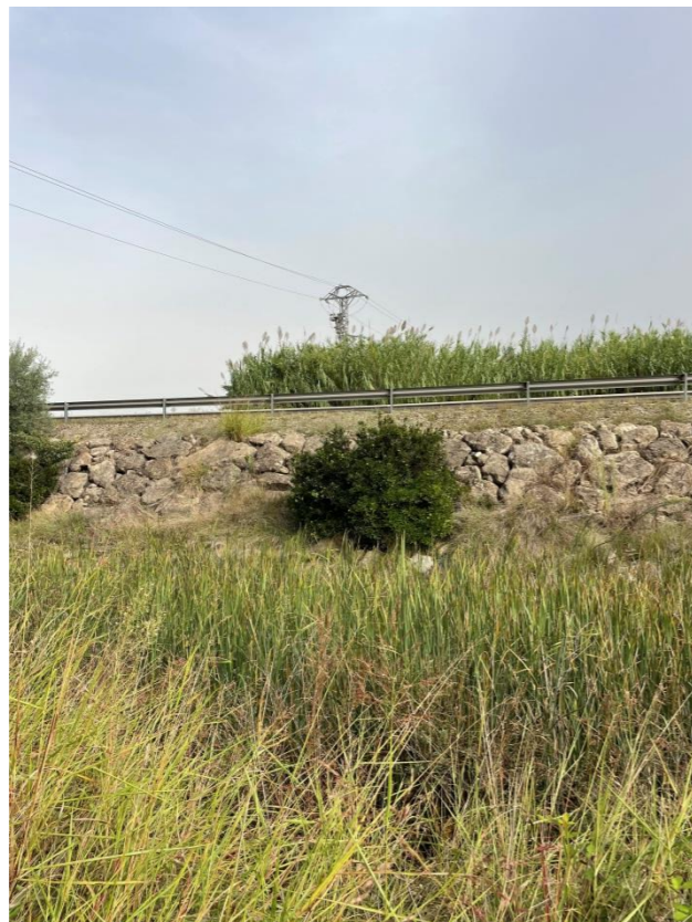
Foto 36.- Detalle tipo encauzamiento del Barxeta en M.D de la CV-41
