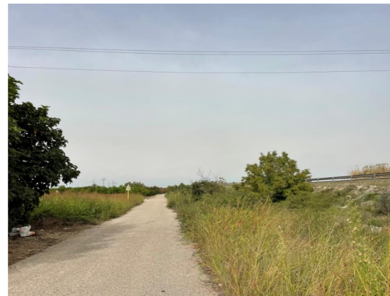
Foto 35.- Detalle del Encauzamiento del Barxeta en la M.D. a pie de la Cv-41. Vista en sentido norte.
