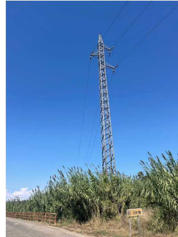
Foto 3. Puente sobre el Rio Verd aguas debajo de la traza.
