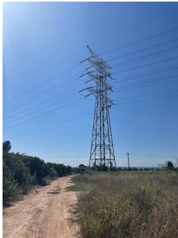
Foto 1. LAMT situada en el PK 30 M.D que no se ve afectada.
