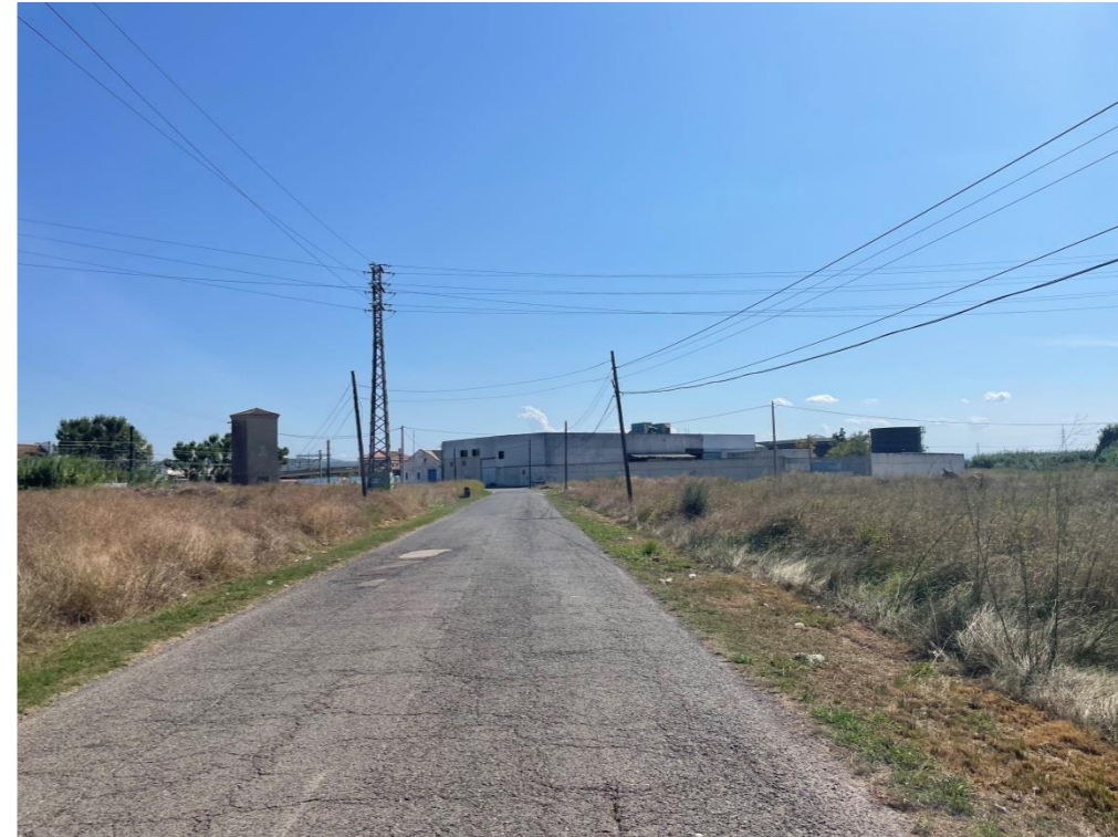
Foto 9.- Carrer Democracia en sentido sur hacia el cruce con la CV-5445
