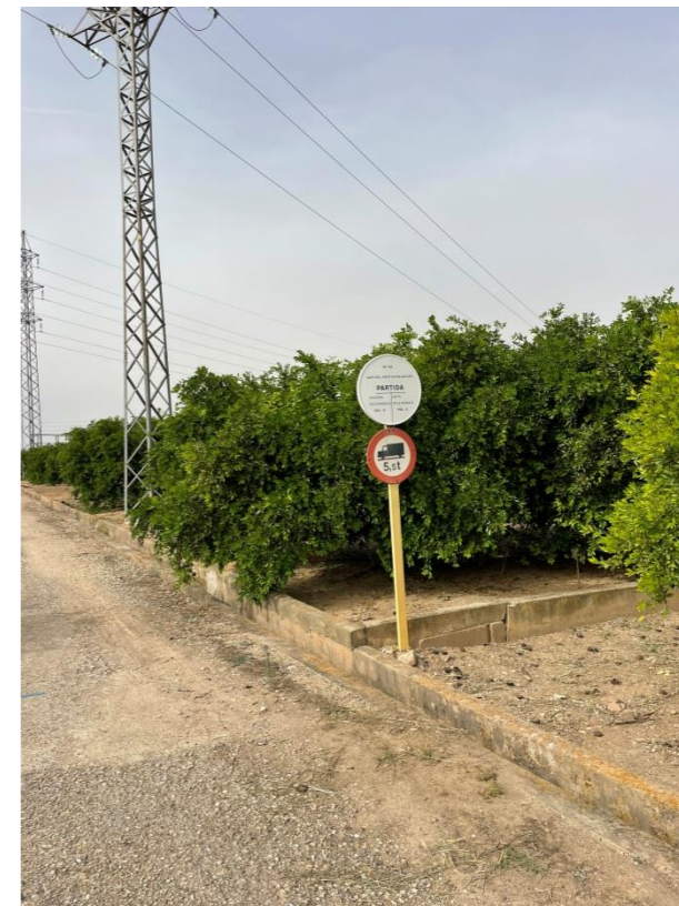
Foto 38.- Detalle Cami del Pont Balaguer y línea afectada por la traza.
