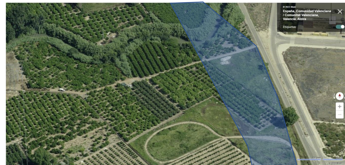
Foto A2.- Trazado en paralelo al Carrer Democracia en el límite con suelo industrial.
