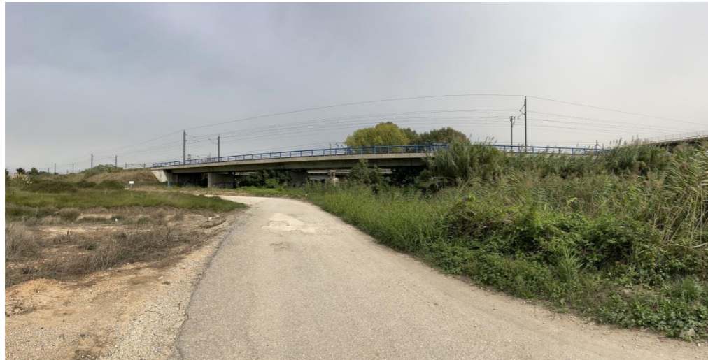
Foto 32.- Detalle vista en sentido norte del puente sobre el Río Júcar, en MD. Encauzamiento del Bco.Barxeta en paralelo a la CV-41.
