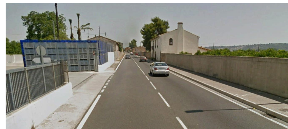
Figura 43. Carretera CV-41(05) – Vía Augusta en el tramo entre Alzira y Carcaixent.
