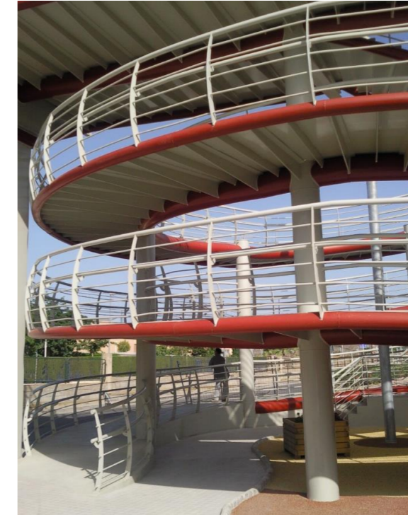
Figura 23. Fotografía de las rampas de acceso de la pasarela con idéntica tipología.
