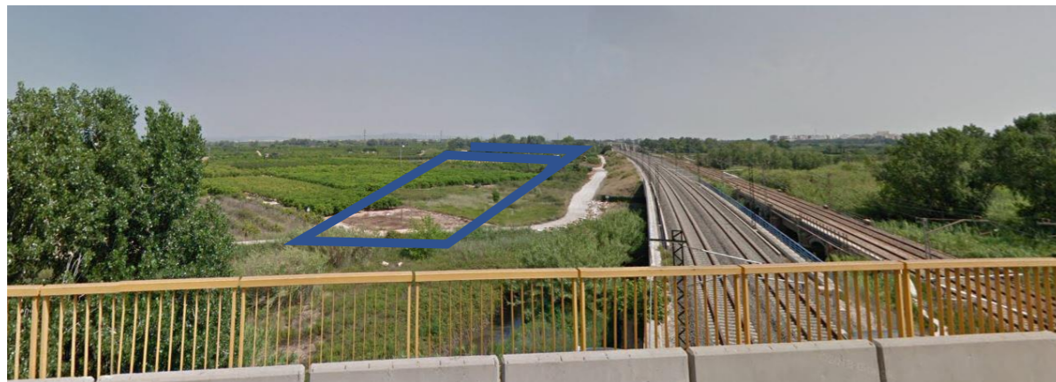
Figura 7. Imagen desde el actual trazado de la CV-41 en sentido norte, apreciándose el paso del ferrocarril y el AVE en paralelo.
