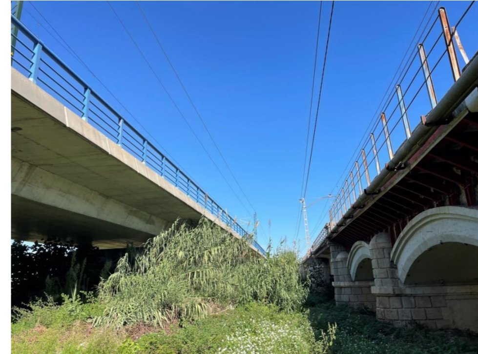
Figura 8. Detalle del tablero del AVE, puente en artesa de ejecución "in situ" y en margen derecha puente del ferrocarril antiguo con hastiales y arcos en piedra.
