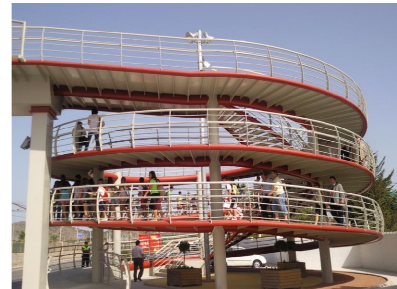
Figura 24. Fotografía de las rampas en espiral de acceso a la pasarela.
