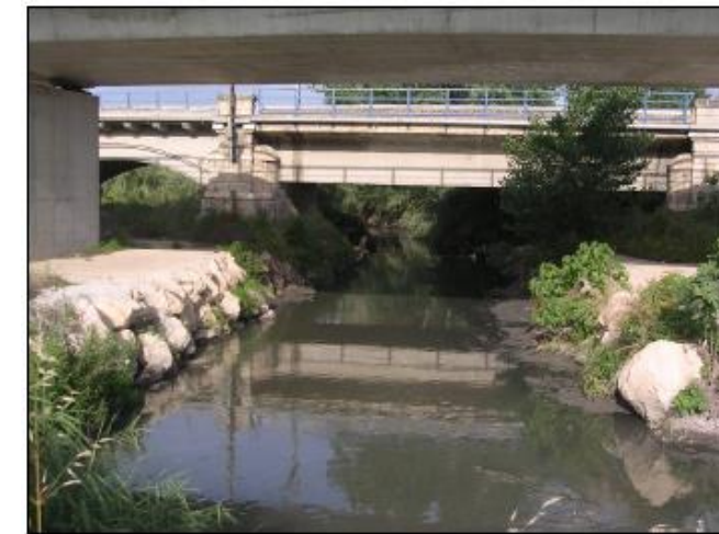
Fotografía 5. Barranco de Barxeta (obras de canalización)
