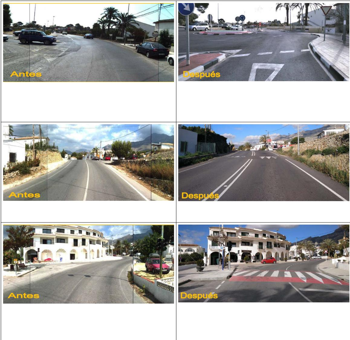
Amplia calzada en la aproximación a la travesía que puede inducir a velocidades inadecuadas en la llegada a la población, intersección en T con elevado tráfico.
