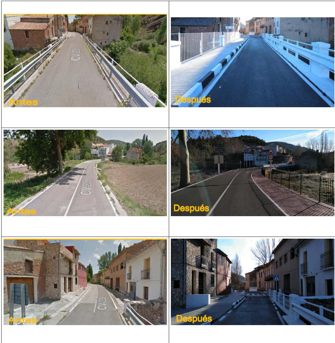
Actuación encaminada a mejorar las condiciones de seguridad de la travesía, con el acondicionamiento de aceras y ejecución de pasos sobreelevados, nuevo andén peatonal hasta el Molino del Infante, y redistribución de espacios y ejecución de acera sobre el tablero del río Palancia.
