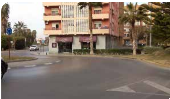
El ferm de les gloriètes està sotmés a fort desgast que el fara lliscant abans que la resta, especialment si hi ha molt de tràfic pesat i girs de xicotet ràdio.
