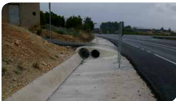
El salvacuneta i el cartell de la imatge representarien obstacles per a un usuari DRM que impactara contra ells, la qual cosa recomana tractar de buscar solucions alternatives quan siga possible.
