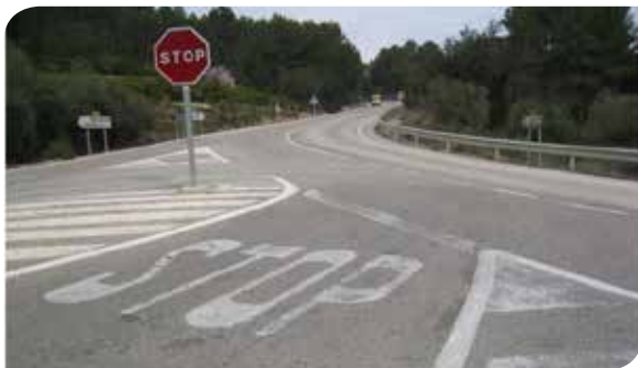
Visibilidad, adherencia y protección de obstáculos, son los aspectos fundamentales a tener en cuenta en el entorno de las intersecciones.
