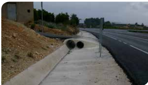
El salvacunetas y el cartel de la imagen representarían obstáculos para un usuario DRM que impactase contra ellos, lo que recomienda tratar de buscar soluciones alternativas cuando sea posible.
