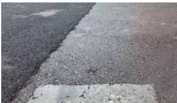
La disminución brusca de la adherencia, si no se percibe con antelación, podría defraudar las expectativas de adherencia de los usuarios.
