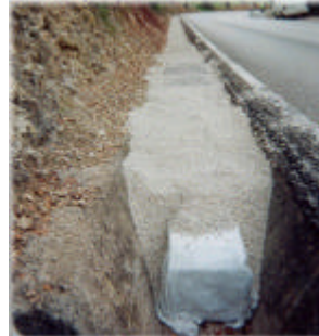
Cuneta modular en ejecución
