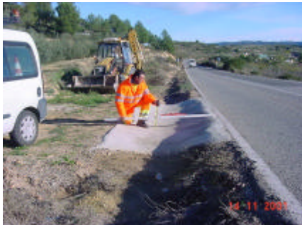
Paso salvacunetas "vadeable" en construcción
