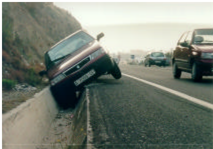
Cuneta infranqueable y sin proteger
