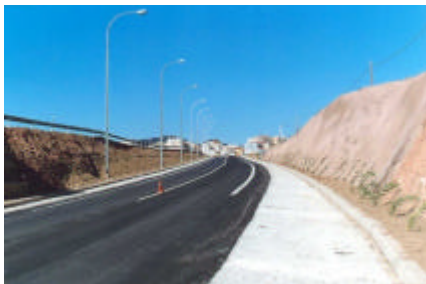
Cuneta suficiente y "amigable"
