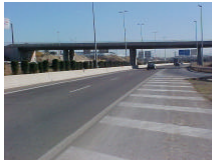
Pilas de puente protegidas
