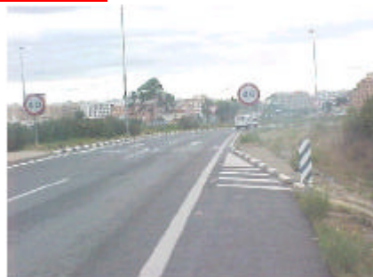
Pérdida de arcén con cebreado insuficiente
