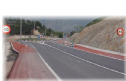
Al paso por la rotonda, el arcén se convierte en carril bici segregado
