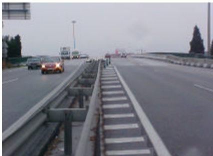
Longitud cebreado igual a distancia de parada y balizas H-75
