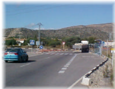
Parada de Bus fuera del tronco....
