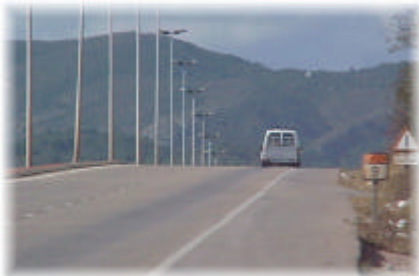
Parada de Bus en cambio de rasante y a costa de ocupar el arcén.
