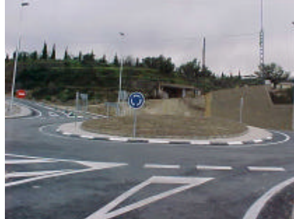
Marcas viales en perfecto estado
