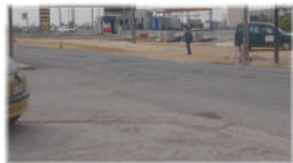
Tramo en obras. No se ven la marcas viales antiguas ni las de obra
