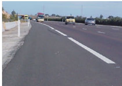
La marca vial resaltada es una muy rentable medida de bajo coste
