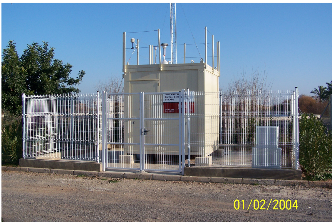
Foto: Estación de SAGUNT-CEA
