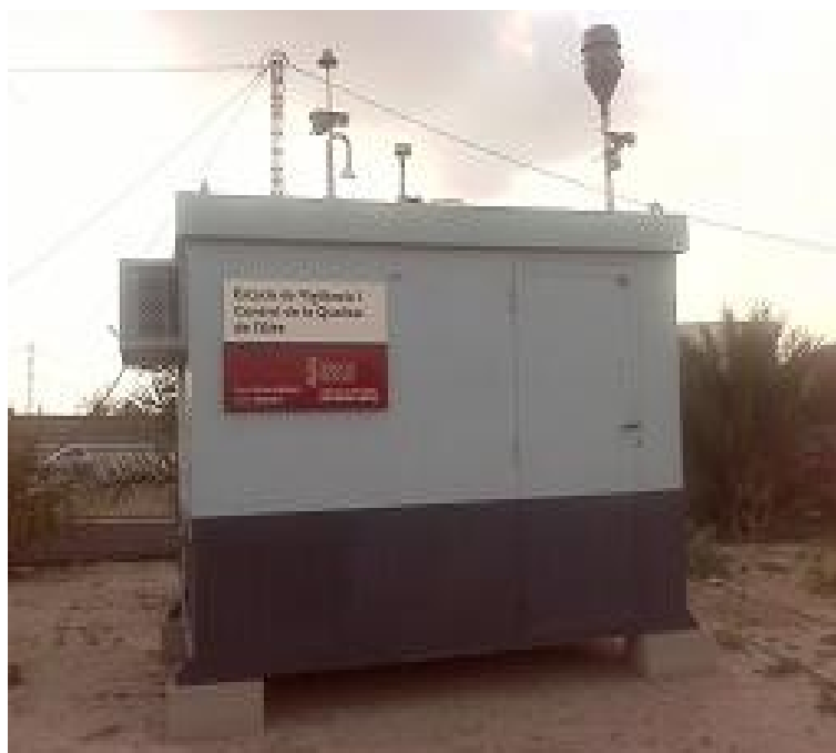
Foto: Estación de ELX-PARC DE BOMBERS
