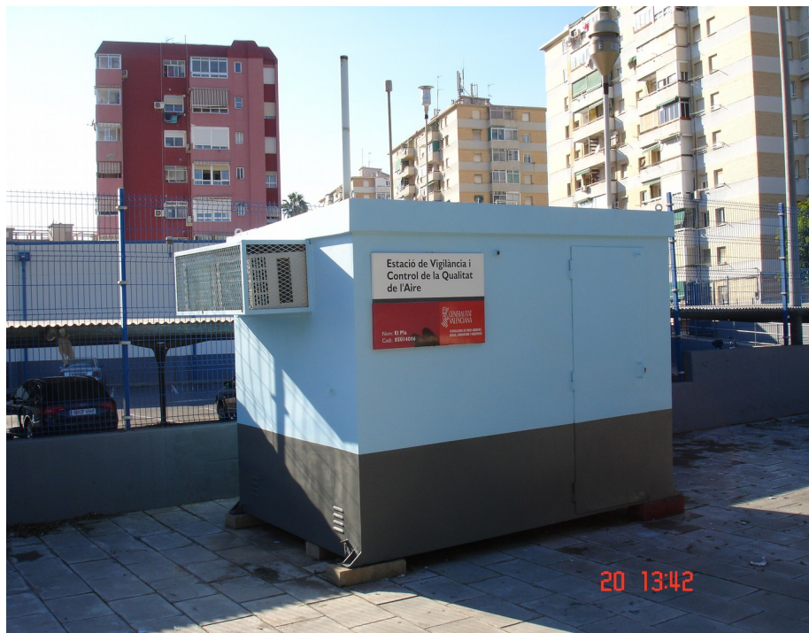
Foto: Estación de ALACANT-EL PLÀ
