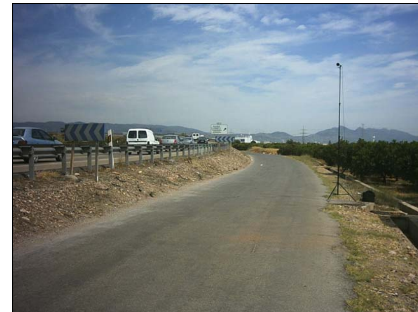
Fotografía 6 Principales focos de ruido. N-340.
