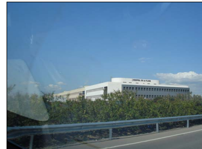
Fotografía 13 Principales focos de ruido. CV-185.A su paso por el Hospital de La Plana.
