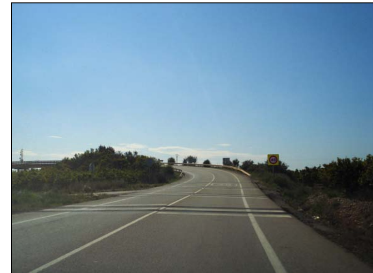
Fotografía 18 Principales focos de ruido. CV-222. Paso elevado cruce AP-7.
