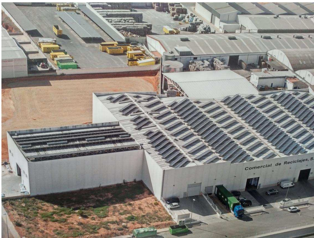
Foto 12: Vista general Comercial Reciclaje
