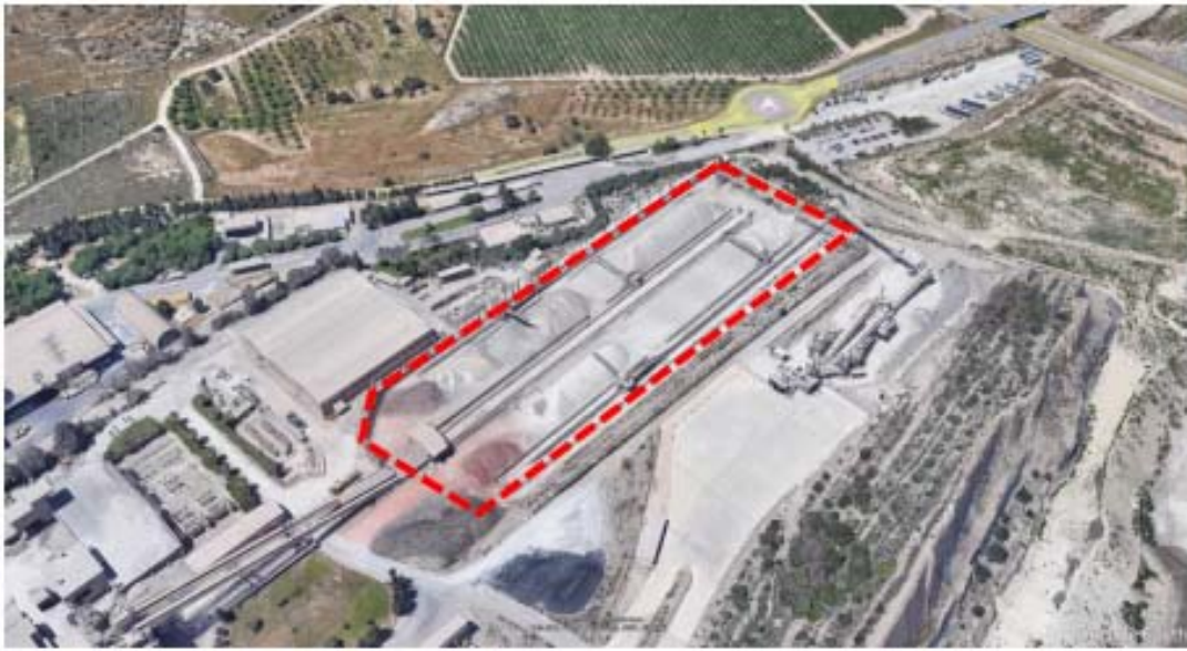
Perímetro de la nave de cubierta
