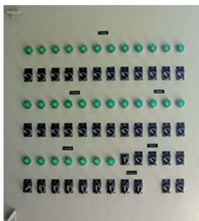
Figura 18. Cuadro de control de un sistema informático de una explotación avícola. Fuente: Fotografía propia.
