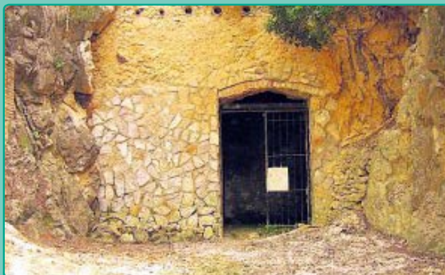
Entrada del túnel de Canals
