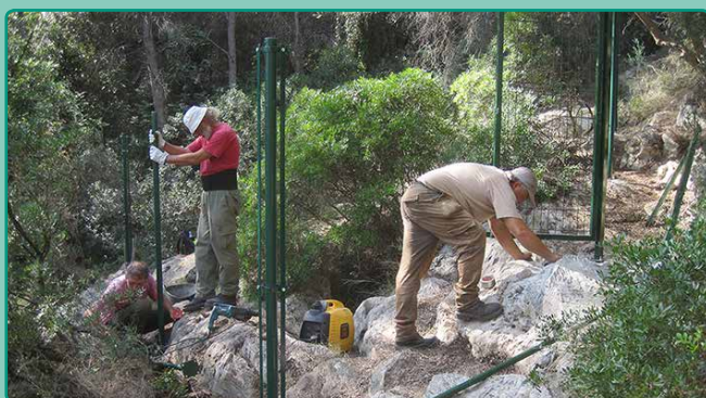
Instal·lació de la tanca perimetral en la Cova Xurra
