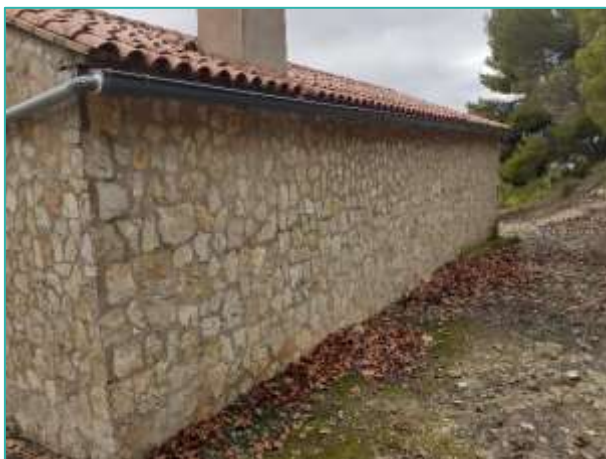
Ilustración 11. Cambio de canal de agua en el área recreativa de Las Morenas, en Utiel
