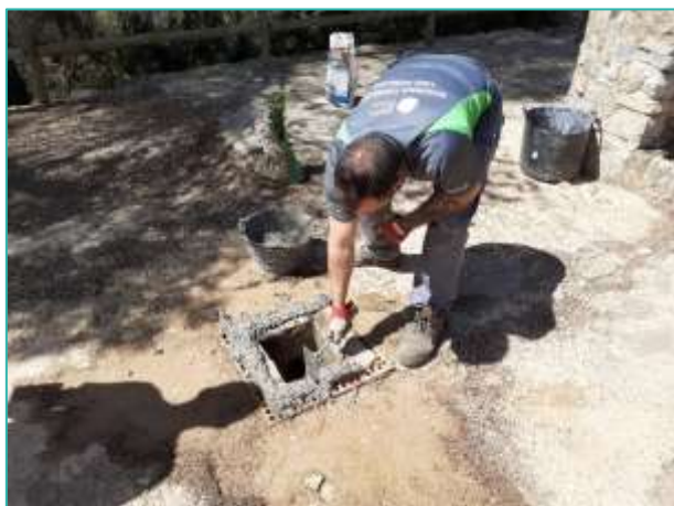
Ilustración 12. Arreglo de arqueta en el campamento de Los Rubiales, en Aras de los Olmos
