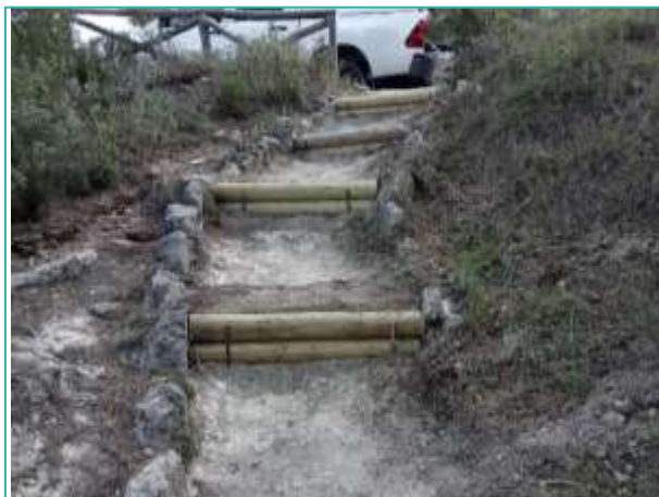
Ilustración 10. Arreglo de escaleras en el área recreativa de la Font de tarragó, en Alfafara
