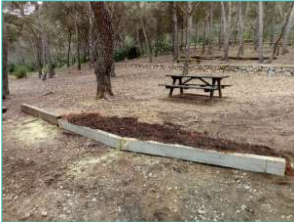
Ilustración 4. Construcción de empalizadas en zonas de cárcavas en el área recreativa de Santo Espiritu, en Gilet
