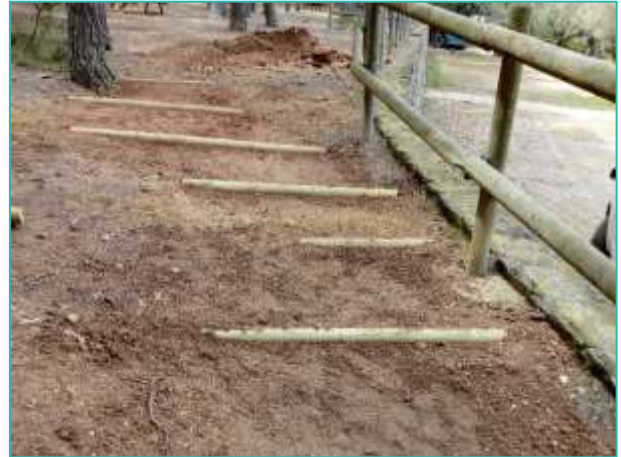
Ilustración 4. Construcción de empalizadas en zonas de cárcavas en el área recreativa de Santo Espiritu, en Gilet
