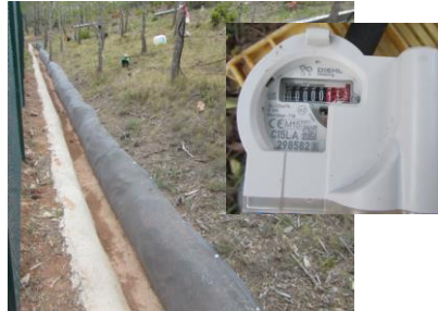
Zanjas y aforos
