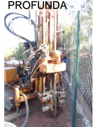
Piezómetros y sensores de nivel
