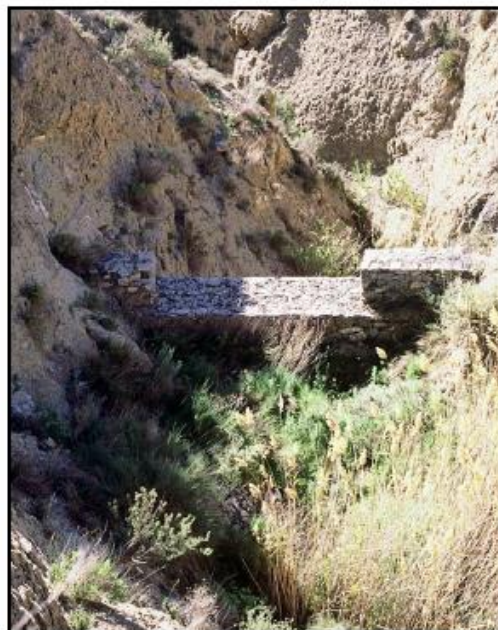
Subcuenca 8 – Vega Baja, T.M. de Albaterra, Barranco de las Ventanas - Dique 7, vista posterior. (Aspecto del dique en el primer inventario).
