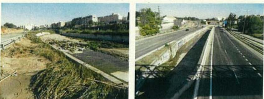
Figuras 5.1 y 5.2. Tramo bajo. Encauzamiento longitudinal del cauce entre muros de hormigón.
