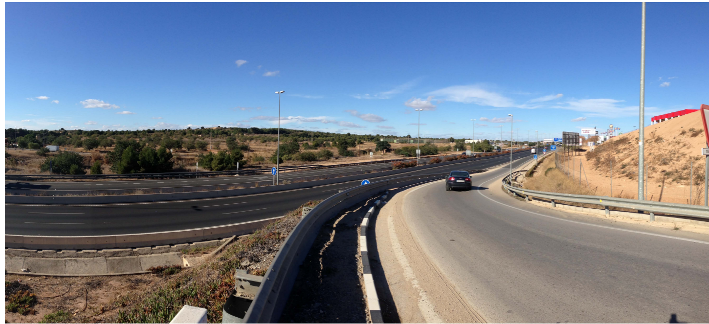
SITUACIÓN ACTUAL. VISTA 4
