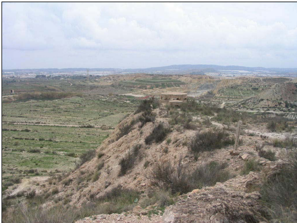
Detalle del pasillo de acceso al puesto fortificado de vigía y de su emplazamiento (abajo)..
