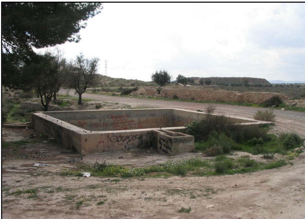
Balsa de grandes dimensiones destinada al almacenamiento de agua de riego para su posterior distribución (arriba) y otra menor con idéntico uso.
