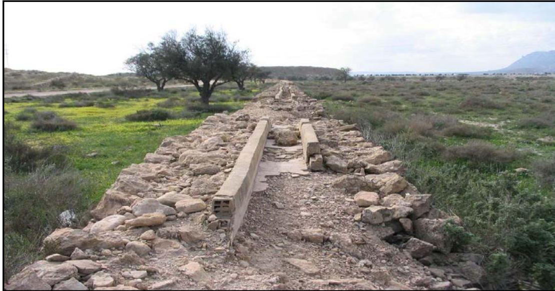
Panorámica de una de las canalizaciones abandonadas.
