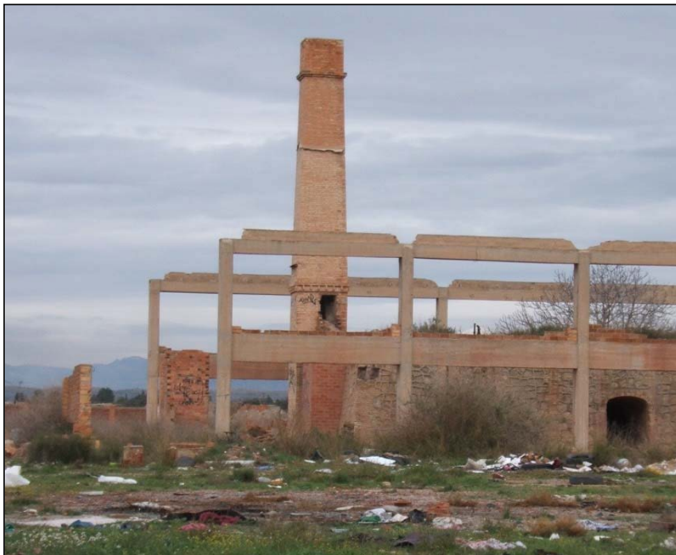
Detalle de la estructura de hormigón del edificio fabril de la industria cerámica (arriba) y de la chimenea y acceso al horno (abajo).
