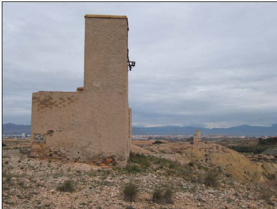
Torreta de luz para el suministro eléctrico de las explotaciones de arcillas.
