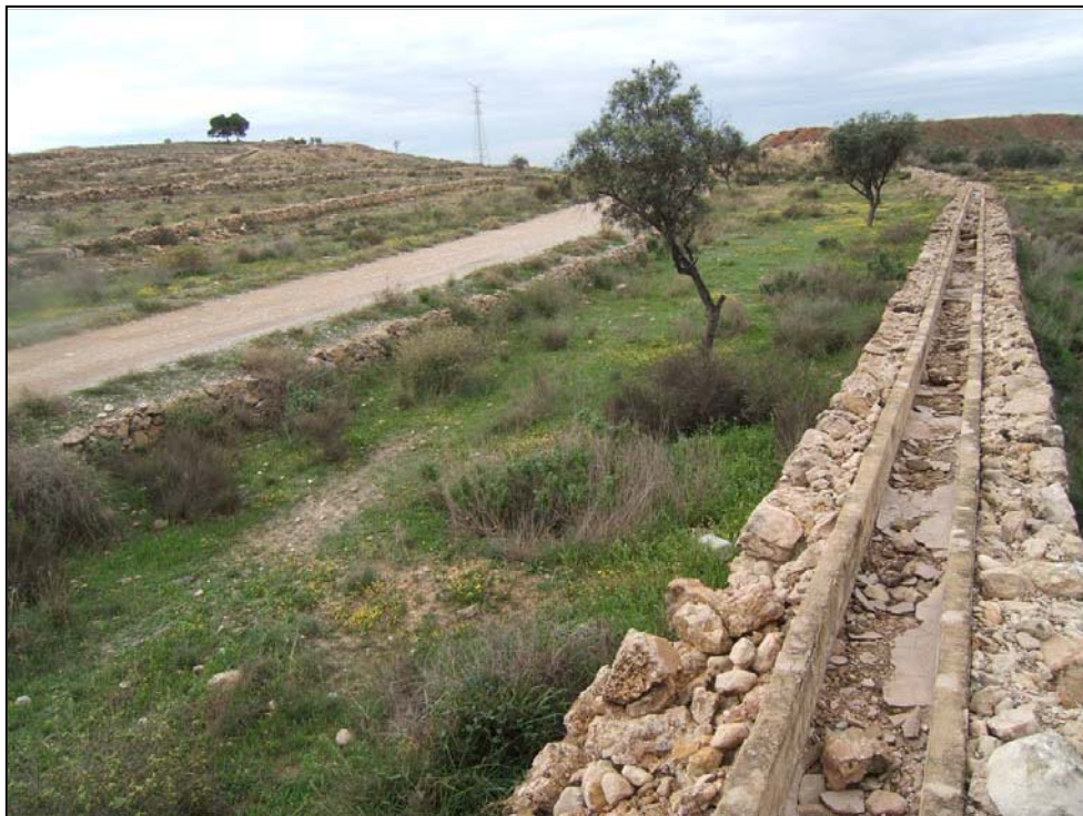
Aljibe destinado al acopio de agua de lluvia y escorrentía superficial para el riego agrícola y abastecimiento antropogénico (arriba) y canalización de ladrillo hueco sobre plinto de mampostería, destinada a la distribución de agua de riego (abajo).
